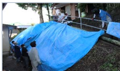
復旧作業をする住民
