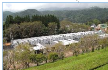
運動公園多目的広場に建設された仮設住宅
