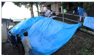
復旧作業をする住民
