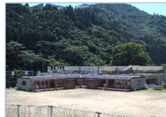
一勝地小の運動場に建設された仮設校舎
