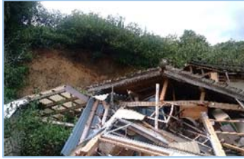
土砂崩れで全壊した家屋
