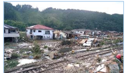
全半壊した茶屋・舟戸地区
