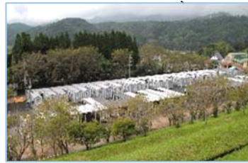
運動公園多目的広場に建設された仮設住宅
