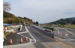
(3/14) 新小川橋開通
