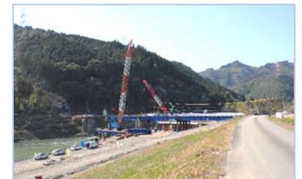
流出した球磨川の相良橋の架橋工事が着々と進んでいる。待ち遠しい!
