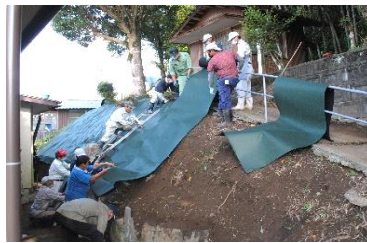
住民で防災シートを張る
